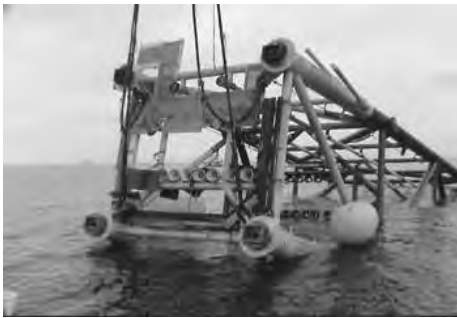
1. ยกโครงสร้างขาแท่นลง จากเรือบรรทุก ณ ตำแหน่งที่กำหนด
