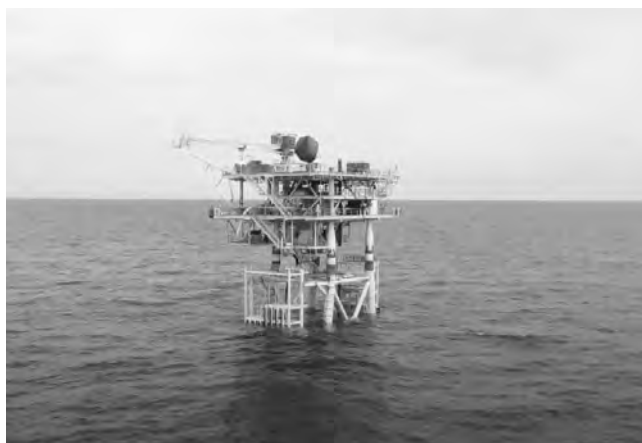
6. แท่นหลุมผลิตที่ติดตั้งเสร็จแล้ว
